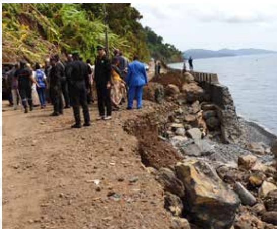
Une équipe de l'OMS est descendue sur le terrain pour constater les dégâts causés par le cyclone Kenneth à Anjouan
