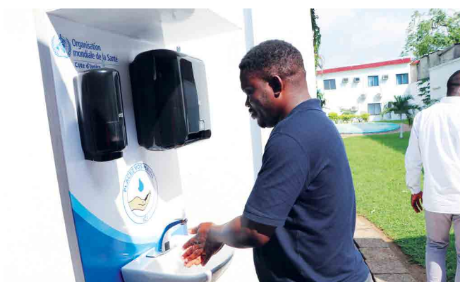
Installation des distributeurs de Gel Hydroalcoolique dans les bâtiments
