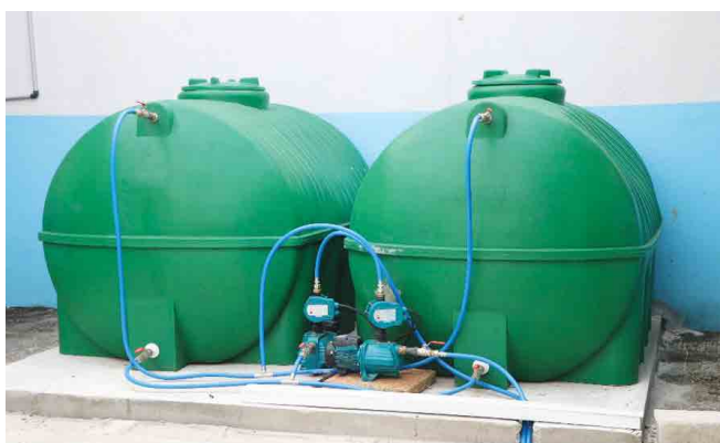
Installation des Bonbones de distribution d'eau dans les bâtiments
