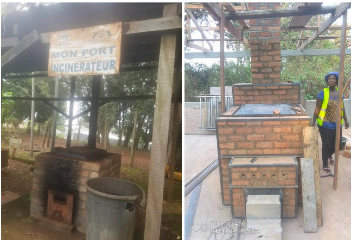
Incinérateur ancien et nouveau en cours de réalisation dans le District de santé de Batouri, Région de l'Est
