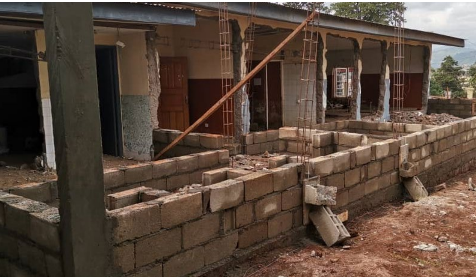
Photo : Unité de soins intensifs de Bamenda pendant la construction
