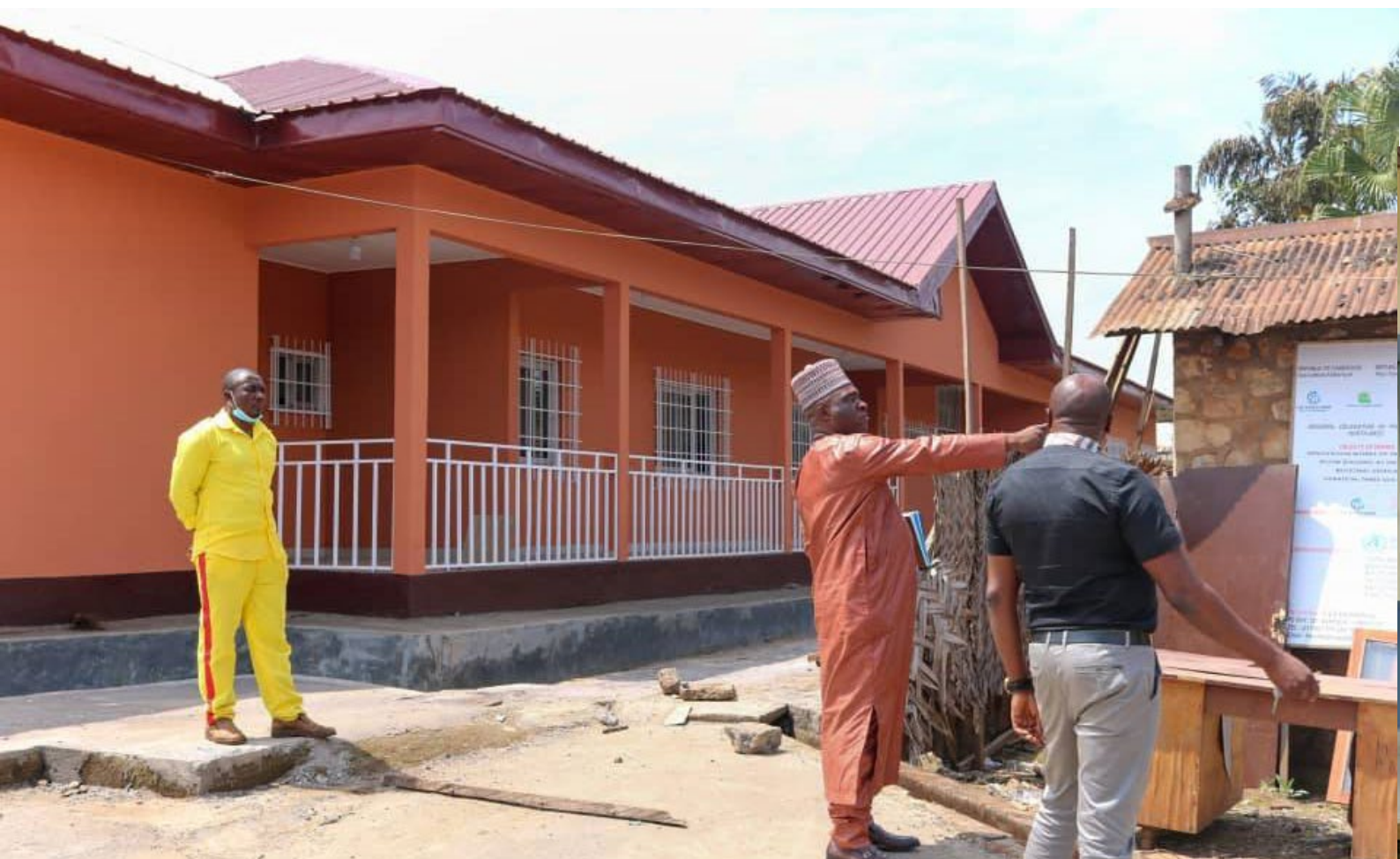
Photo : Centre des opérations des urgences de santé publique (COUSP) de Bamenda refectonné
