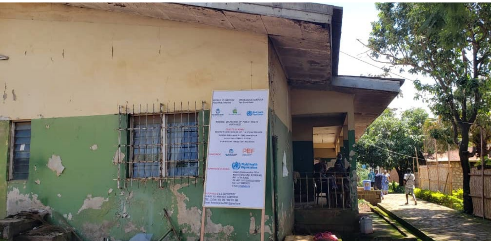
Photo : Centre des opérations des urgences de santé publique (COUSP) de Bamenda, avant les refectons
