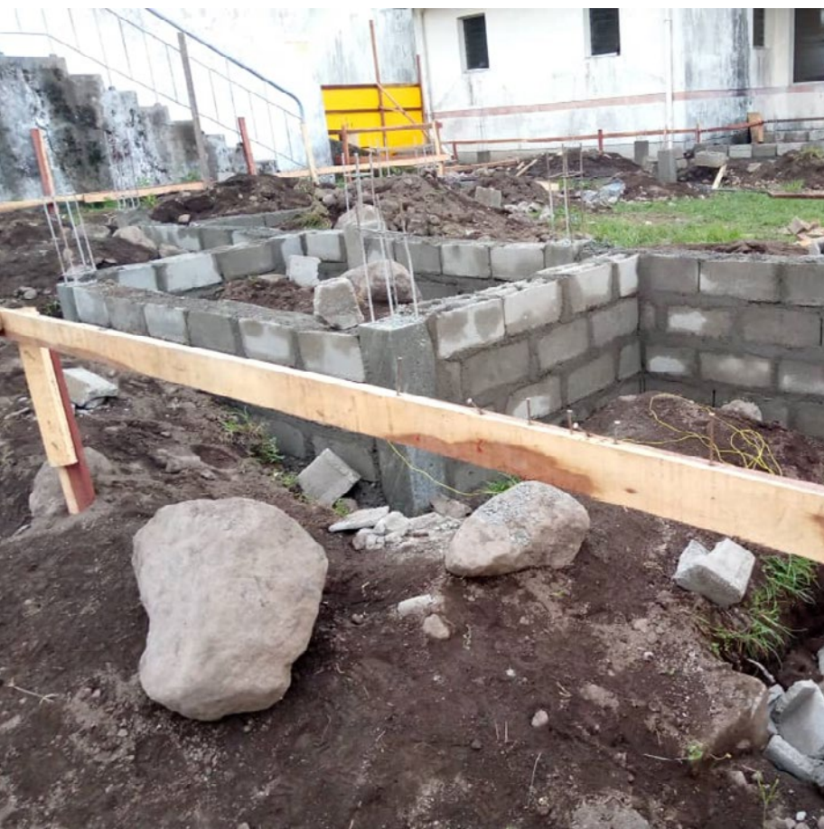
Photo : Unité de soins intensifs de Buea pendant la construction
