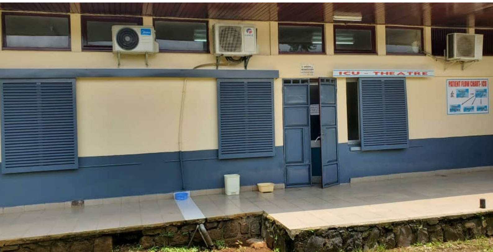
Photo : Unité de soins intensifs de Limbé réhabilitée
