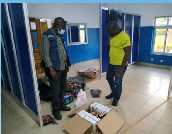
Installation du système d'approvisionnement en oxygène dans l'unité de soins intensifs (Nord-ouest)
