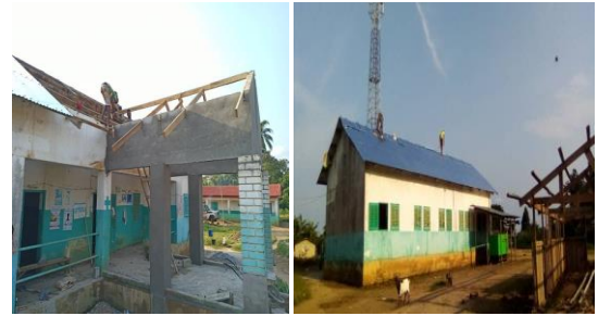
Réfection de la toiture du CSI de Tsiaki
