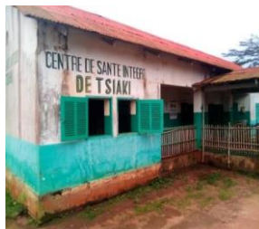
CSI de Tsiaki avant le début des travaux
